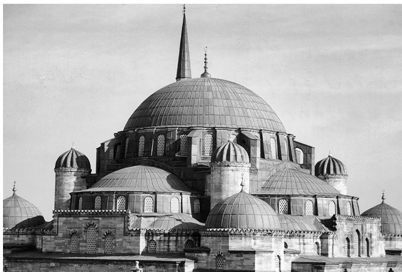
Slika 8: Izgled stepenaste kompozicije krovnih elemenata u Şehzade džamiji. (Foto: autor)
